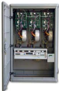
Regolatore/stabilizzatore con regolazione del flusso luminoso da 230 a 175V, con programmatore di cicli orari
